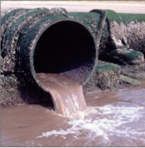
شكل (١١٧) إحدى قنوات الصرف الصحي
