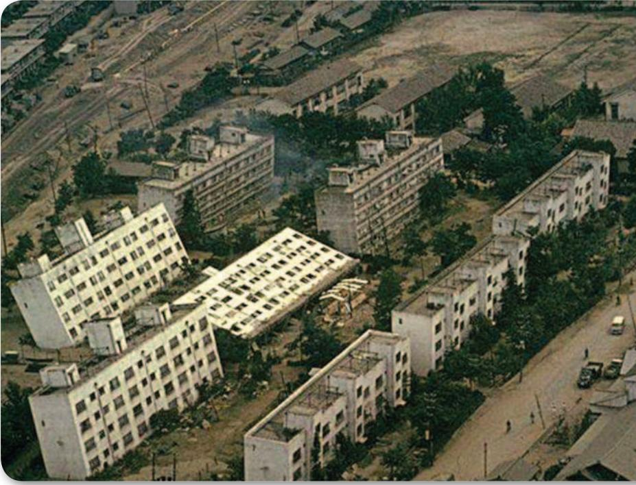
■ الشكل 18-3 يحدث تسييل التربة في التربة الضعيفة التماسك عندما تنتشر اهتزازات زلزالية فيها، فتسلك سلوك الرمال المتحركة.
