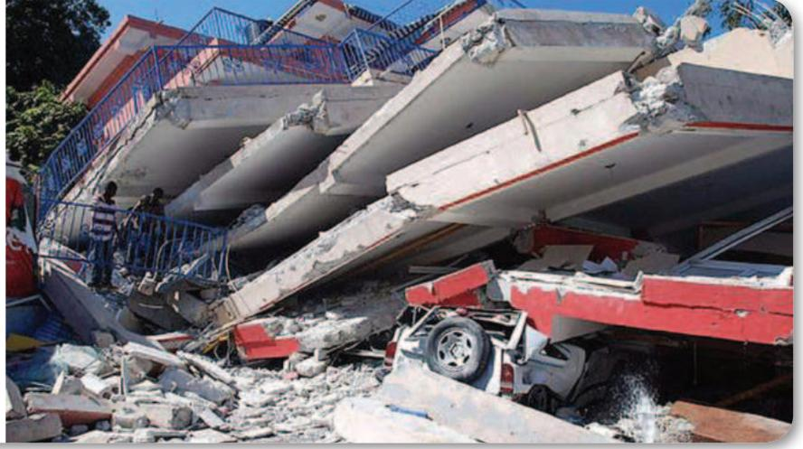
**انهيار المنشآت Structural failure** يحدث في كثير من المناطق المعرضة للزلازل انهيار للمباني عندما تهتز الأرض من تحتها؛ وفي بعض الحالات، قد تنهار الجدران الداعمة في الطابق الأرضي فتسبب في انهيار الطوابق العليا، وسقوطها فوق الطوابق السفلية، فيتشكل حطام يشبه كومة من الفطائر، لذا تسمى هذه العملية صنع الفطائر pancaking، ويوضح الشكل 16-3 دماراً مأساوياً ناتجاً عن هذا النوع من انهيار المنشآت، والذي وقع في إسلام آباد في باكستان، في عام 2005 م.
