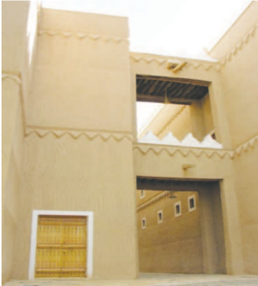
الشكل (٢) البيوت الشعبية في منطقة المربع بالرياض
