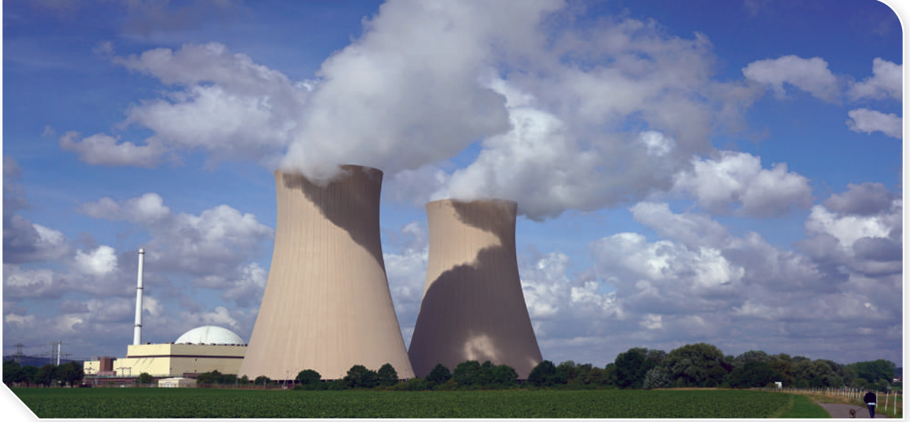
الشكل (14): أبراج التبريد يتصاعد منها بخار الماء.
