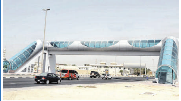
جسر للمشاه لتسهيل قطع الطريق
