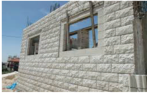
البناء بالحجر الصخري اثناء الإنشاء
