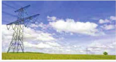
شكل (٢-١٧): ينقل التيار الكهربائي عبر كابلات معدنية محمولة بأعمدة عالية.
