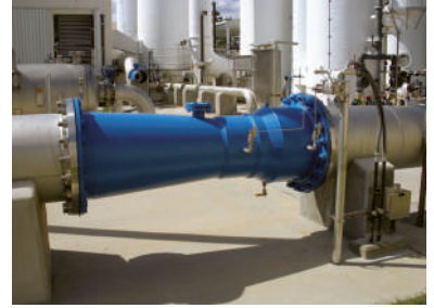
الشكلُ (33): مقياسُ فنتوري في إحدى محطاتِ المياهِ.
