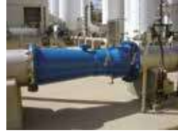
الشكل (33): مقياس فنتوري في إحدى محطات المياه.
