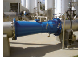
الشكل (33): مقياس فنتوري في إحدى محطات المياه.
