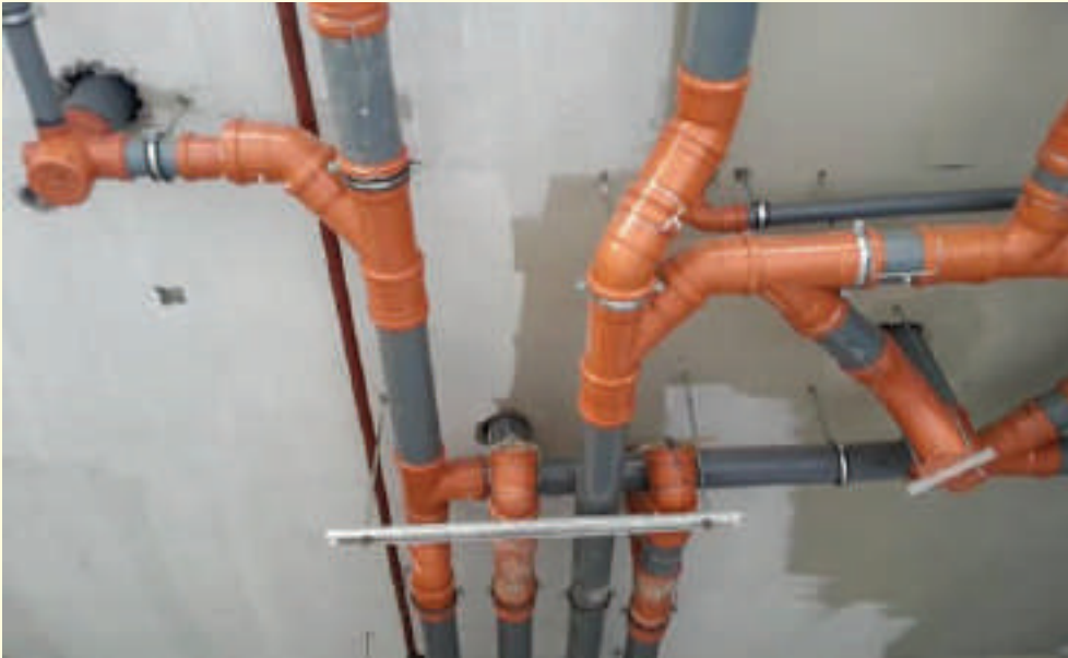
الشكل (13): صورة لجزء من شبكة أنابيب لأحد التمديدات الصحية.
