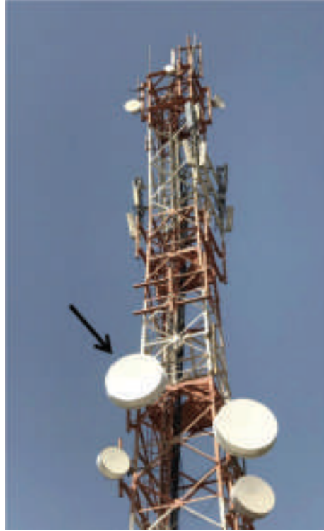
الشكل (4): أبراج الاتصال في نظام الميكروويف.
