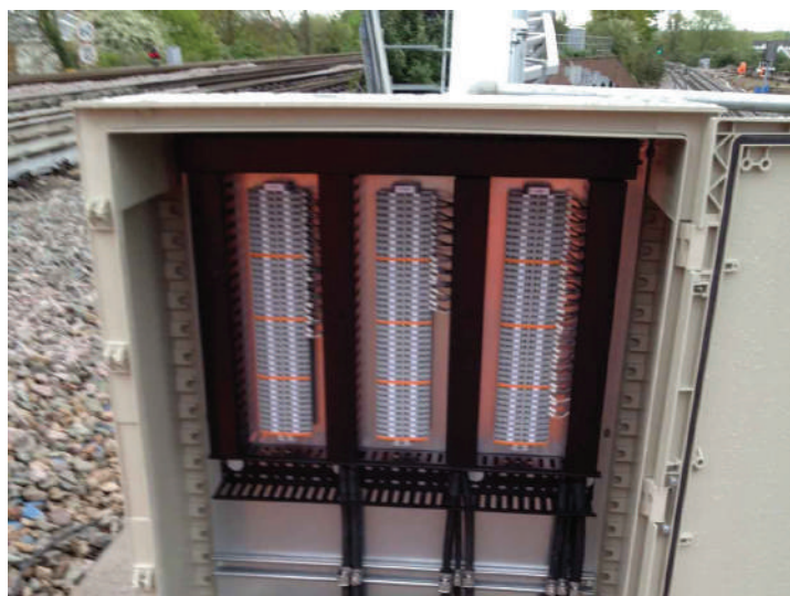
الشكل (3): خزانة (كبينة) التوزيع الرئيسية.
