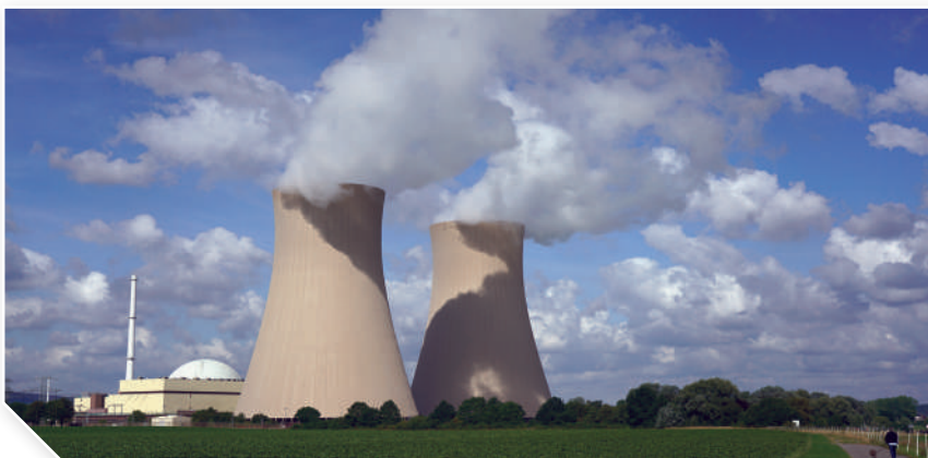
الشكل (14): أبراج التبريد يتصاعد منها بخار الماء.
