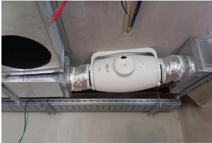
ثُرِّكَب على مجاري الهواء وهي مروحة، إمّا أن تكون لسحب الهواء من الخارج لإدخال الهواء الخارجي للنظام، وإمّا أن تكون مروحة سحب أي إخراج الهواء من النظام إلى الخارج، ويحدد ذلك اتجاه السهم الموجود عليها؛ فإن كان السهم إلى الداخل كانت مروحة سحبًا، والعكس صحيح.
