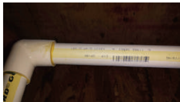
الشكل (4-12): تمديد الأنابيب البلاستيكية (CPVC).
