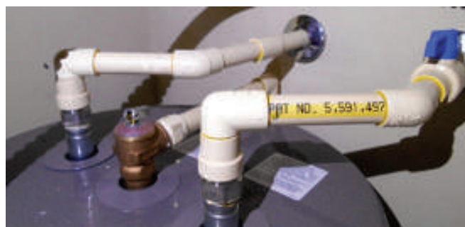
الشكل (4-12): تمديد الأنابيب البلاستيكية (CPVC).
