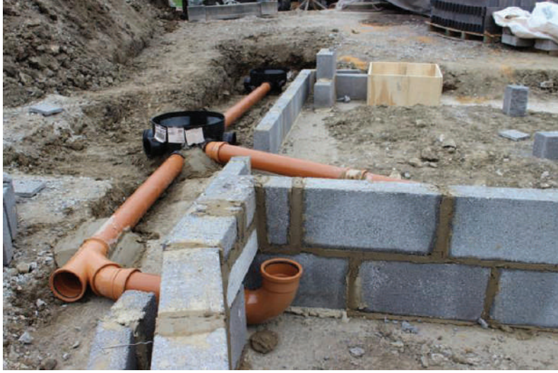
الشكل (2-5): شبكة التصريف الخارجية للمبنى.
