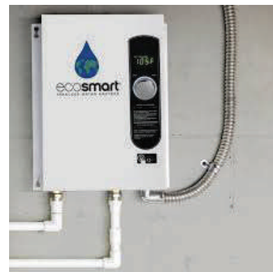
الشكل (11-7): سخان الكهرباء الفوري لمجموعة من القطع الصحية.
