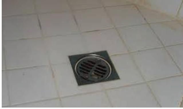
الشكل (5-12): مصفاة السيّفون الأرضية
