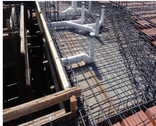
الشكل (1-5): شبكة التصريف الداخلية للمبنى في أثناء التأسيس.
