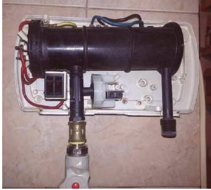
الشكل (16-7): مقطع من السخان الكهربائي الفوري.
