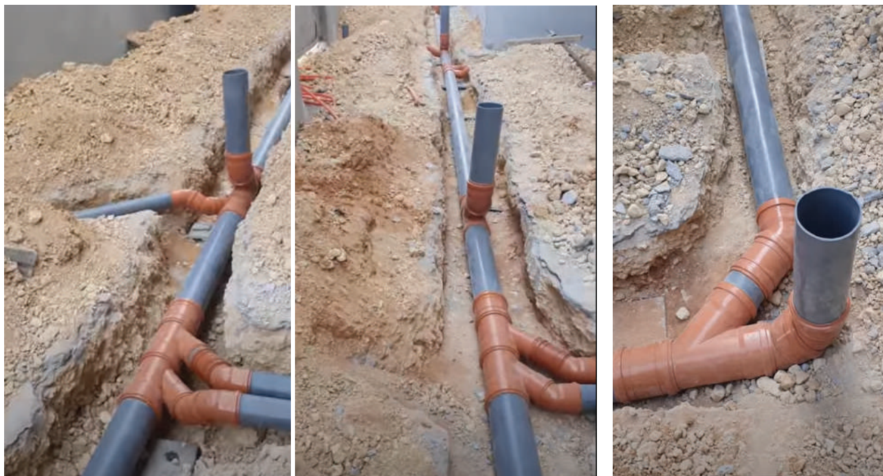
الشكل (8-5): تركيب فتحات تنظيف
