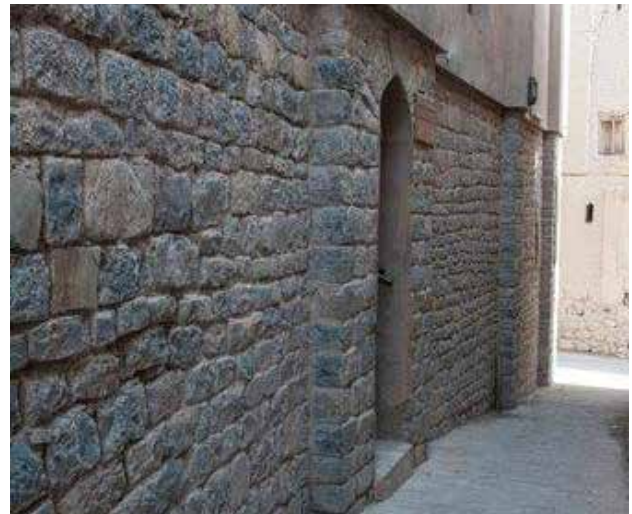
الصورة ٩-٢ مسجد الشواذنة بحلّة العقر في ولاية نزوى المبني من صخور ومواد بناء تُعدّ من الموادّ المشعّة الطبيعية
