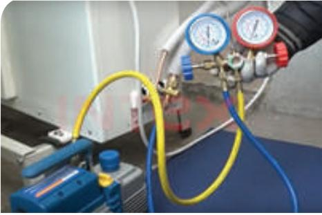
2 صل فتحة ساعة الضغط المنخفض بالخرطوم الأزرق وصل الطرف الآخر بجهاز التبريد.
