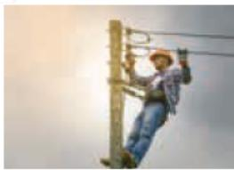
بأن يراعي إجراءات السلامة عن طريق لبس الخوذة والقفافيز التي تجنبه الصدمة الكهربائية، وأن يستخدم الأدوات الالزمة مثل الأربطة التي تجنبه السقوط أثناء العمل على أعمدة الكهرباء.
